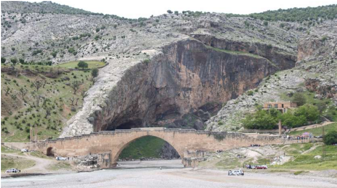
Resim 3. Cendere (Septimius Severus) Köprüsü (Kaya Derinoğullu 2015)
